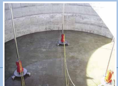
Installazione di aeratore sommerso tipo SC. Installation of a submersible aerator type SC.
