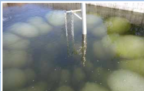
Fasi di avviamento di aeratore sommerso radiale. Starting stages of a radial submersible aerator.
