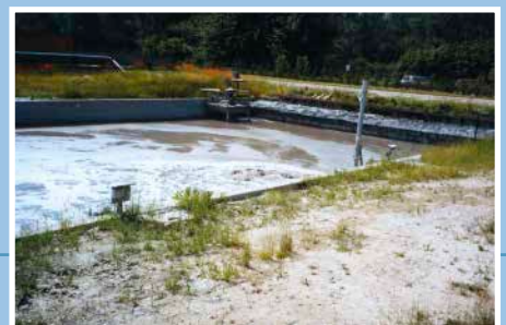
Installazione di aeratore sommerso tipo Air-Get. Installation of a submersible aerator type Air-Get.
